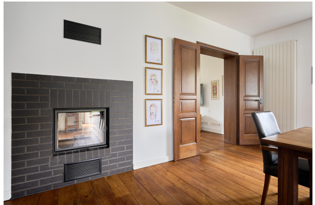
Kamin mit Pufferspeicher für die Gasheizung
